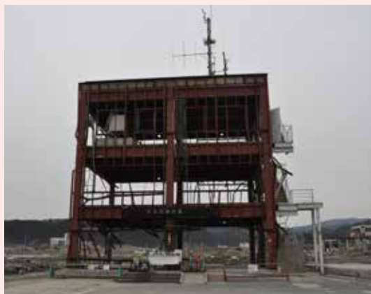
東日本大震災の津波で骨組みだけとなった南三陸町の防災対策庁舎。近く取り壊される予定。「(保存は) づらい記憶が蘇る」という地元の方の意見もありました。(2011年12月8日撮影)
